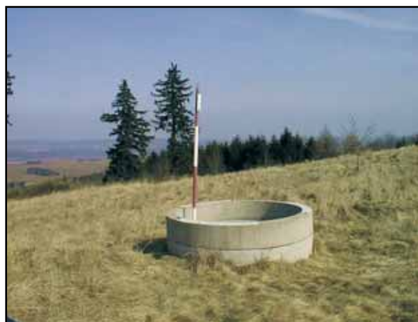
Nivelační bod. Leveling point. foto - Ivo Krčmář
